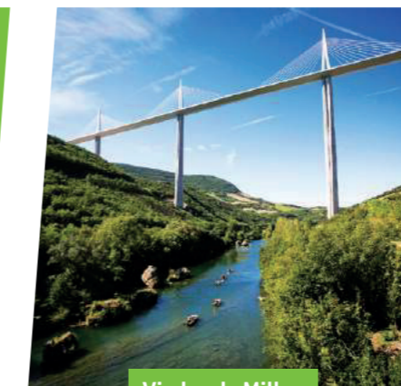
Viaduc de Millau
