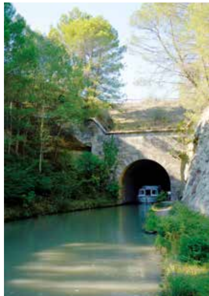
📍 Le tunnel du Malpas
