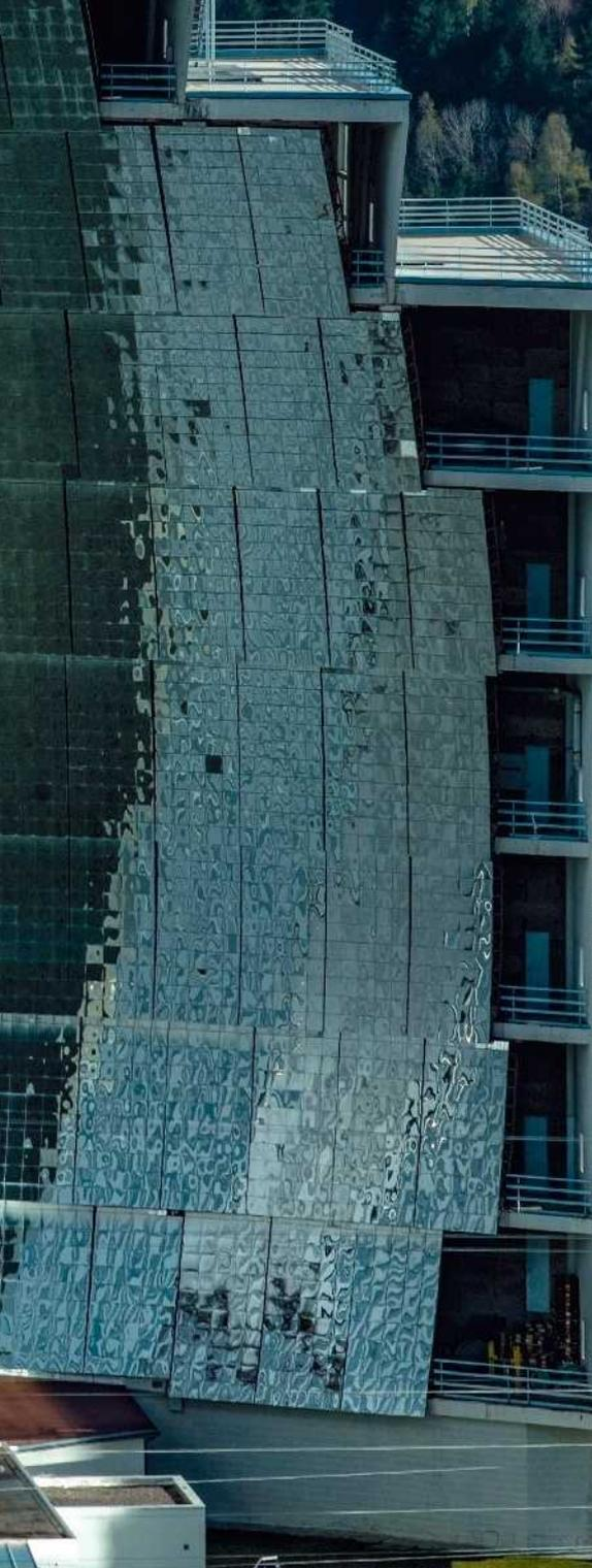
Ci-dessus : les miroirs du four solaire d'Odeillo, une star de technologie et de recherche depuis sa mise en service en 1963 : avec ses 50 m de haut et ses 63 héliostats, concentrant près de 10 000 fois la puissance du soleil, il est toujours le second plus grand four solaire au monde...
