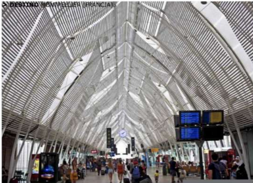
Interior de la estación de tren.
