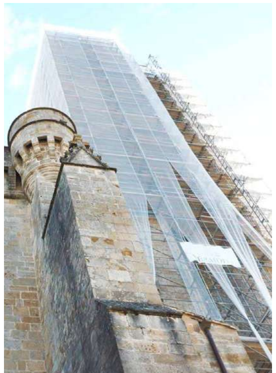
Le clocher avec son échafaudage
