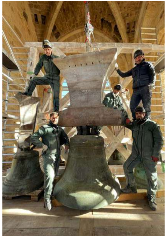
La pose de «Lou Gran Campan» sur le beffroi en chêne par Azur Carillon
