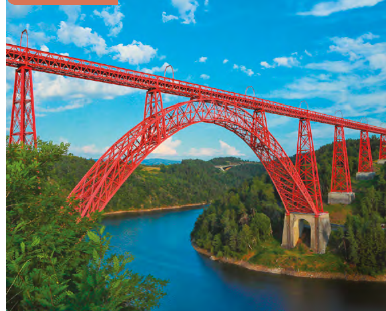
Viaduc de Garabit
